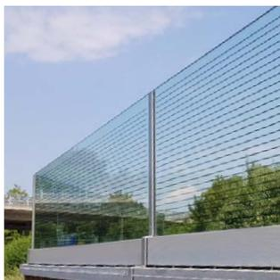
Image 9: Des lignes horizontales noires de 2 mm de large et d'un passage utile de 28 mm ont obtenu, contre toute attente, de très bons résultats lors des tests en laboratoire.<sup>1</sup> [Archiv Schweizerische Vogelwarte]
