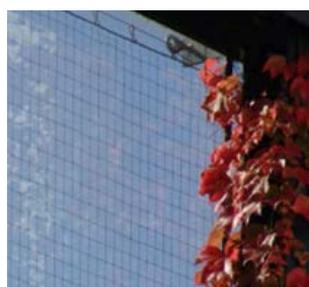
Image 5: Cette barrière antibruit en verre a été rendue visible grâce à un grillage métallique fin.<sup>3</sup>
