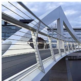
Image 10: Solution similaire de Jakob Rope Systems: Câbles horizontaux comme garnissage de garde-corps sur une passerelle en Angleterre.
