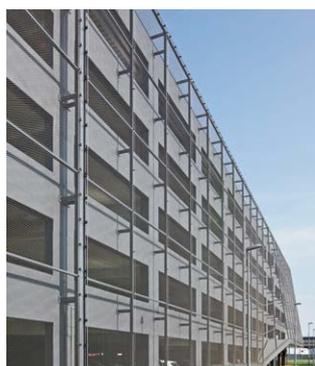
Image 12: Effet similaire de filets de protection de Jakob Rope Systems dans un parking de Zürich.
